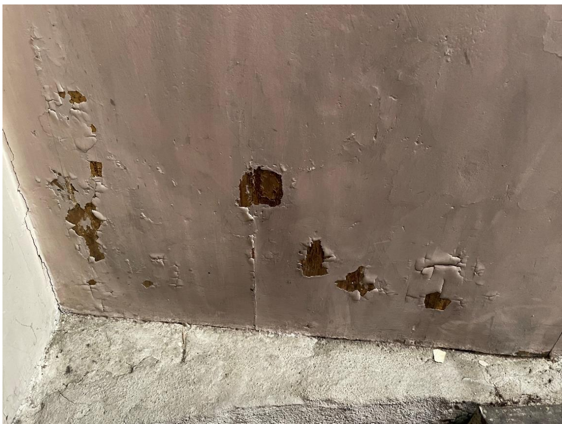
Fot.3. Więclawice Stare, kościół p.w. św. Jakuba Apostoła, ołtarz główny. Na zdjęciu widoczna skala zniszczeń powłoki malarskiej w dolnej części szafy ołtarzowej (odspojenia, spęcherzenia oraz ubytki farby).
