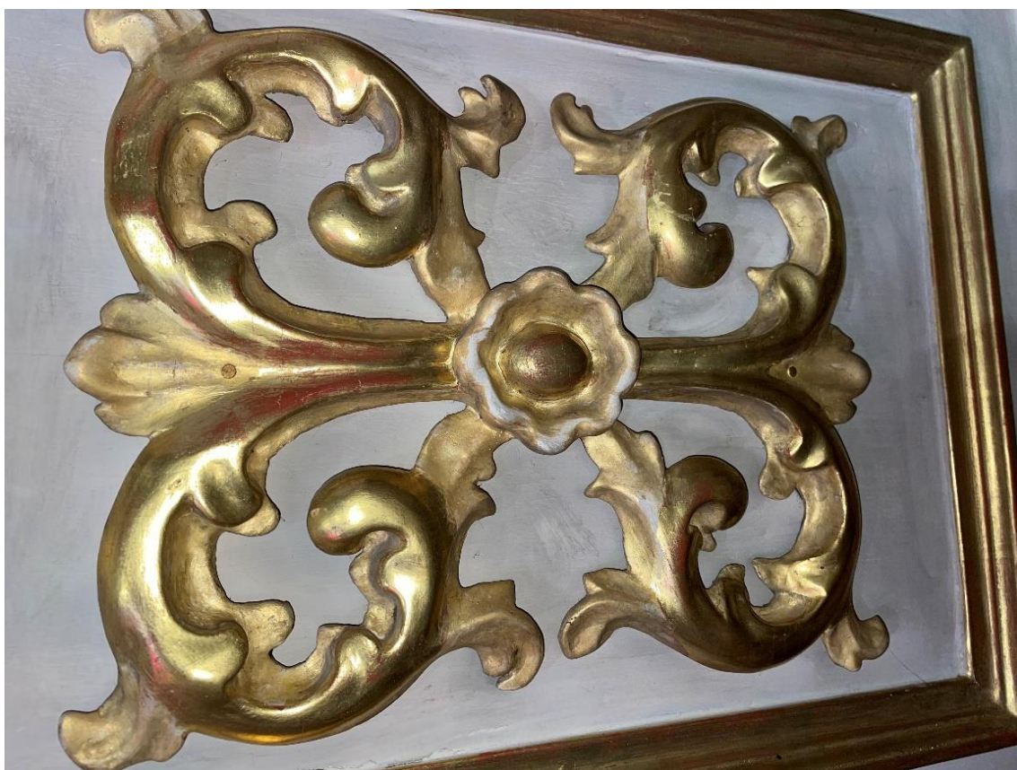
Fot.5. Więclawice Stare, kościół p.w. św. Jakuba Apostoła, ołtarz główny. Widoczne silne przetarcia warstwy złocen.
