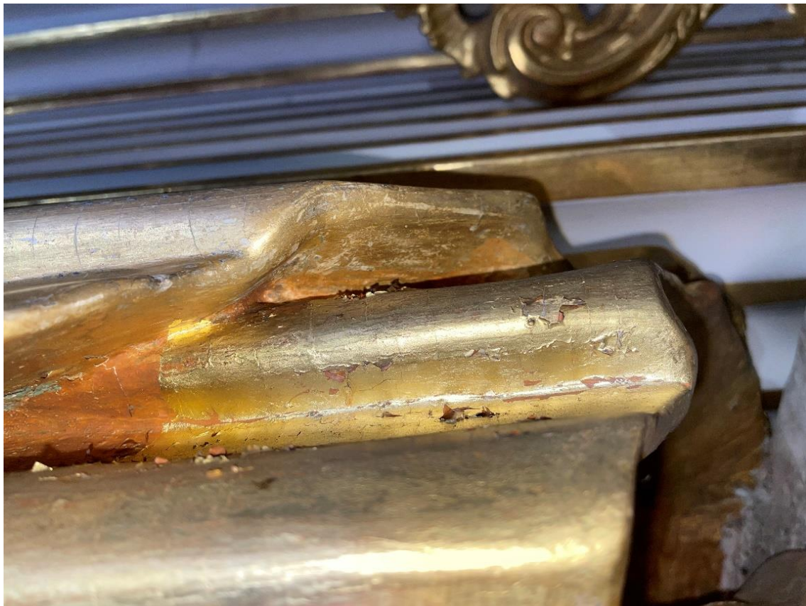
Fot.6. Więclawice Stare, kościół p.w. św. Jakuba Apostoła, ołtarz główny. Widoczny destrukcja warstwy złota w dolnej części rzeźby przedstawiającej św. Piotra (odspojenia, spęczenia, ubytki).
