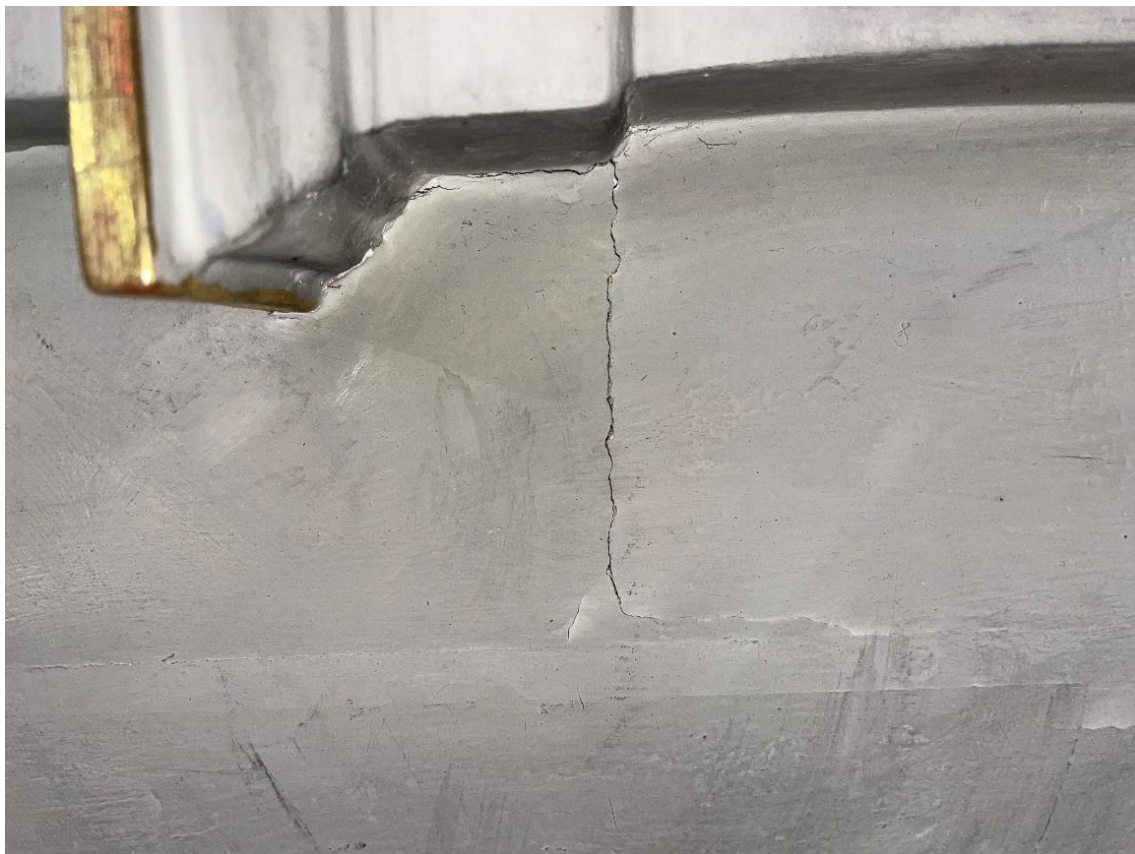
Fot.9. Więclawice Stare, kościół p.w. św. Jakuba Apostoła, ołtarz główny. Na zdjęciu widoczna skala zniszczeń powłoki malarskiej w dolnej części szafy ołtarzowej (spękania farby, nalot kurzu). Fot. Joanna Sawicka- Jaskot, 2024 r.
