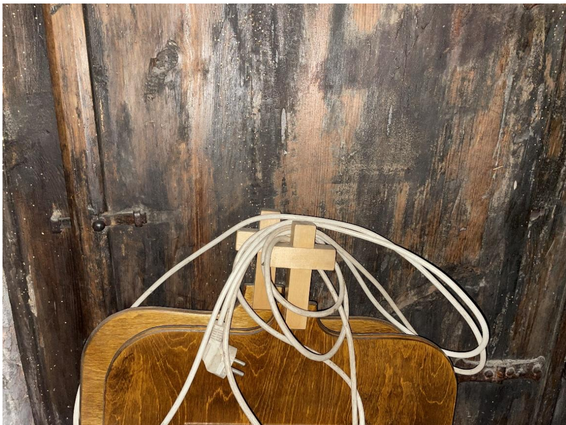
Fot.15. Więclawice Stare, kościół p.w. św. Jakuba Apostoła, ołtarz główny. Odwrocie drzwiczek umieszczonych z prawej strony ołtarza. Widoczne uszkodzenia powierzchni drewna, powstałe na skutek urazów mechanicznych.
