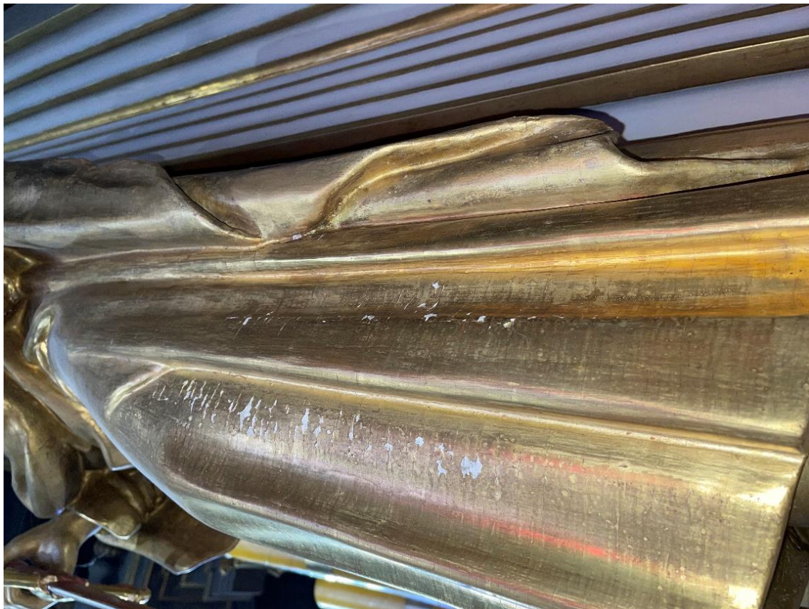
Fot.8. Więclawice Stare, kościół p.w. św. Jakuba Apostoła, ołtarz główny. Widoczne spękania oraz ubytki warstw technologicznych (rzeźba przedstawiająca św. Piotra). Fot. Joanna Sawicka- Jaskot, 2024 r.
